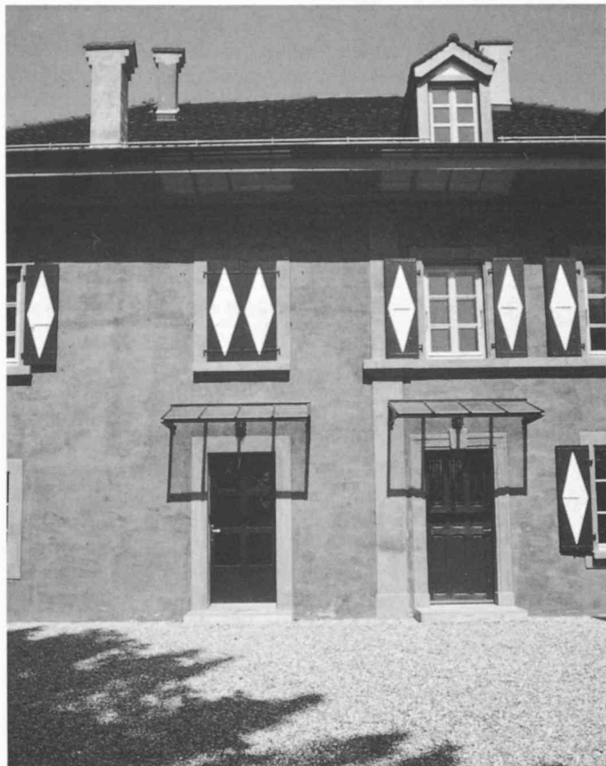
Vue partielle de la façade sur jardin
