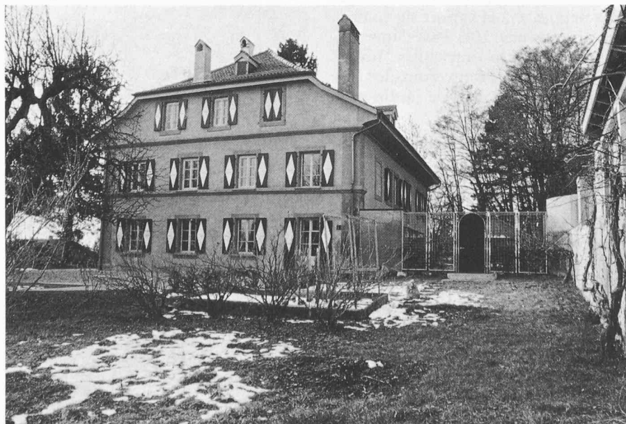
La démolition de l'ancienne annexe permet de rééquilibrer la façade et de mettre en relation la cour et le jardin
