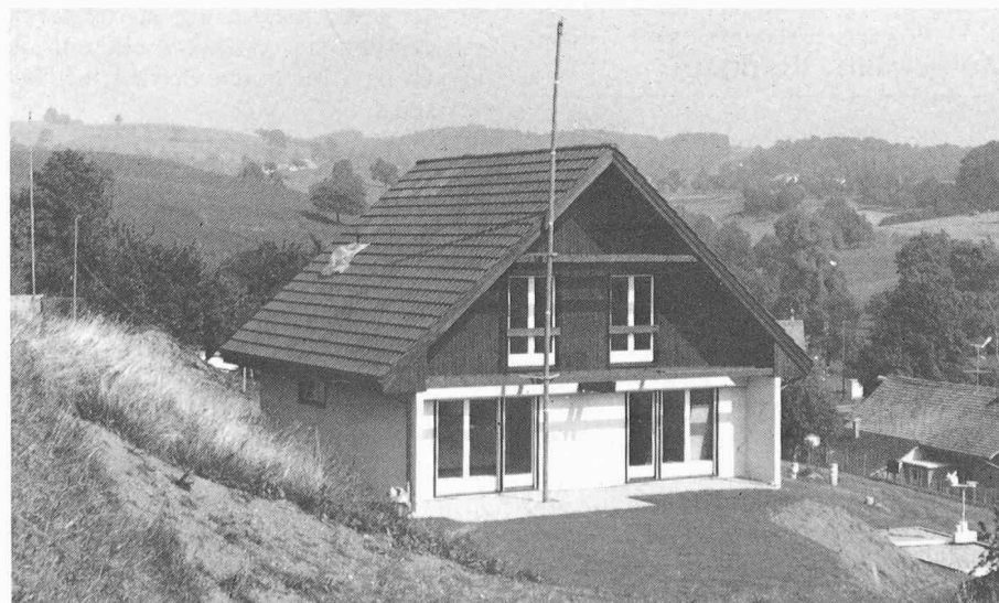
Bild 1. Messgebäude, Ansicht von Westen
