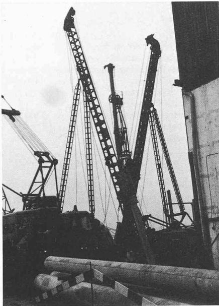
Bild 15. Rammeinrichtungen, die auf engstem Raum arbeiten
