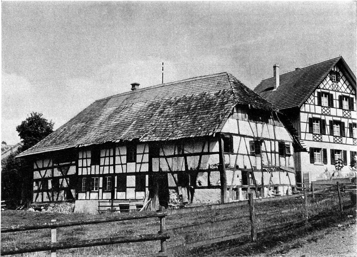
Abb. 1. Vielzweckbau in Fachwerk-Bauweise mit Walmdach, im Wirtschaftsteil rechts sind durchgehende Ständer und Langstreben sichtbar. Ueßlingen TG
