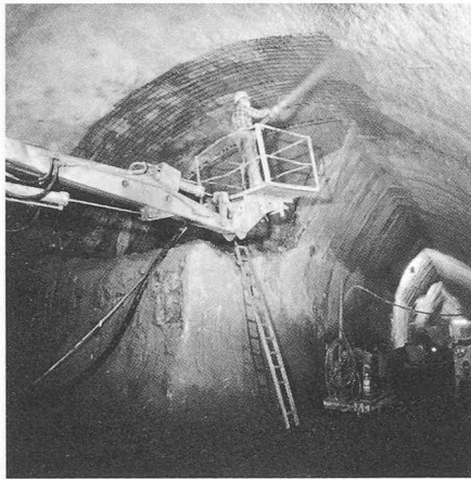
Bild 16. Spritzbetoneinbau im Firstbereich im Tunnelbau
