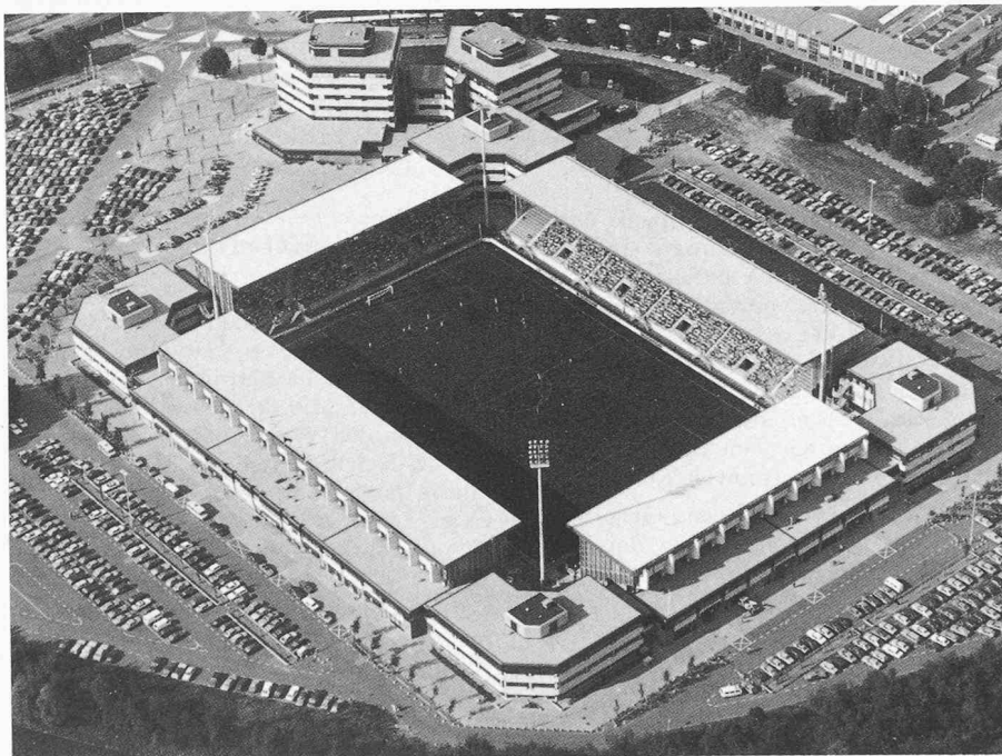
Bild 1. Fussballstadion Galgenwaard in Utrecht für 20 000 Zuschauer auf überdachten Tribünen
