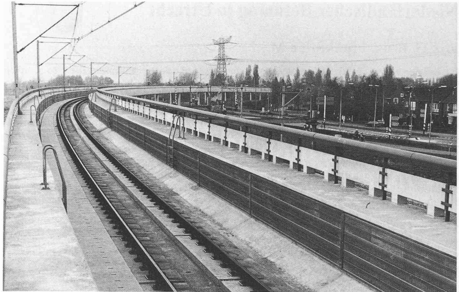
Bild 5. Blick in den Trog mit direkter Schienenauflegung und schallschluckender Auskleidung
