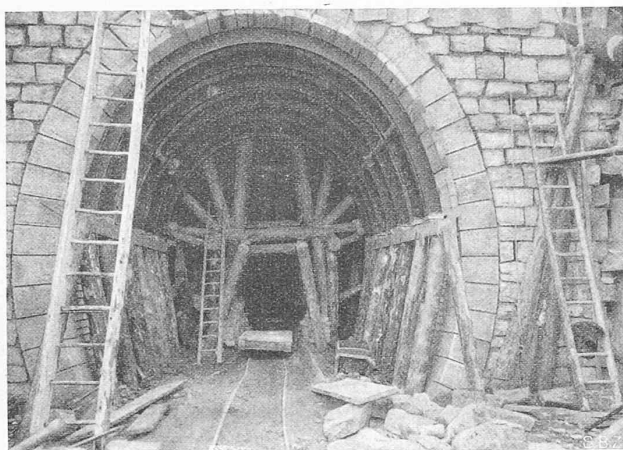
Abb. 5. Unteres Portal des Kehrtunnels. Bauausführung Prader & Cic.
