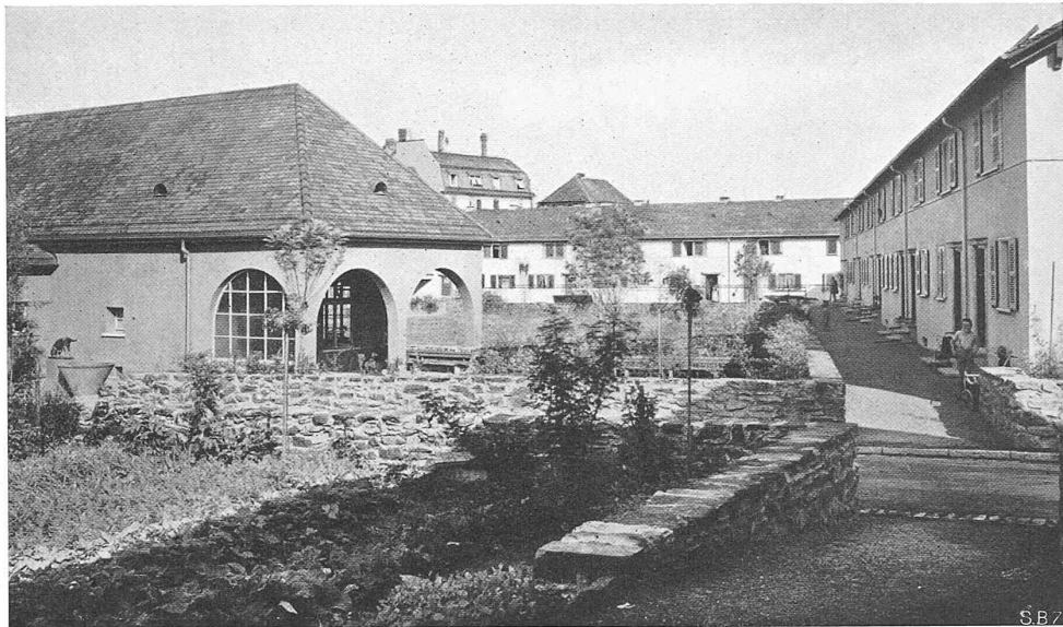
EINBLICK AUS NORDWEST IN DEN RASENHOF, LINKS KINDERGARTENHAUS STÄDTISCHE WOHNKOLONIE HEURIED IN ZÜRICH ARCHITEKTEN KÜNDIG & OETIKER, ZÜRICH
