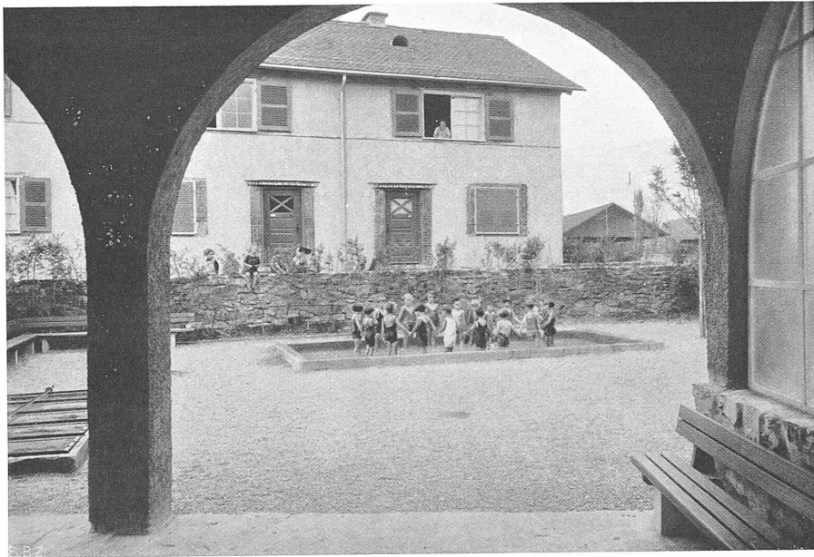
BLICK AUS DER SÜDWESTL. KINDERGARTEN-HALLE GEGEN DAS PLANTSCHBECKEN STÄDTISCHE WOHNKOLONIE HEURIED IN ZÜRICH ARCHITEKTEN KÜNDIG & OETIKER, ZÜRICH
