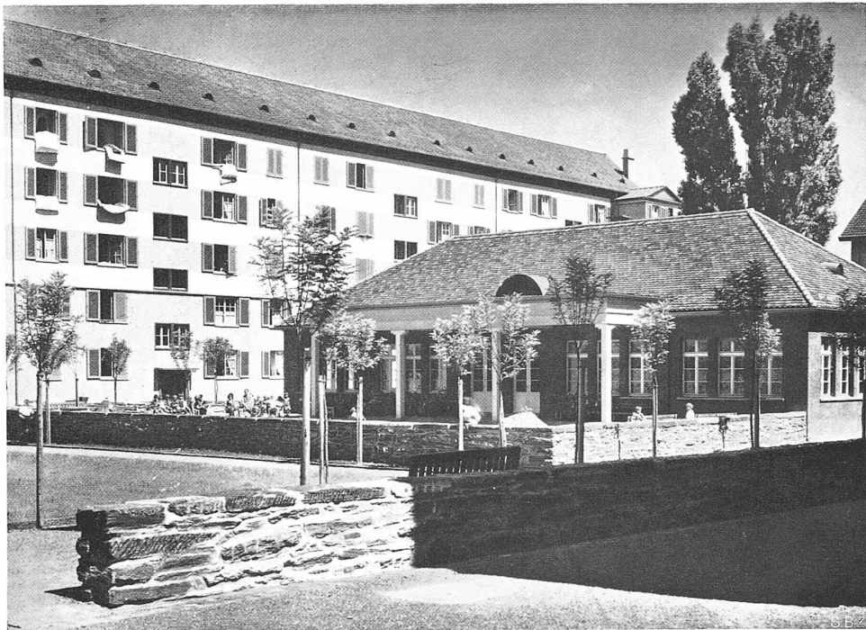
KINDERGARTENHAUS IM GARTENHOF
