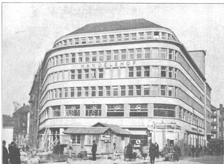
Geschäftshaus Handelshof, Zürich 1.
