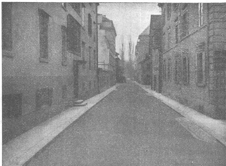
GLÄRNISCHSTRASSE ZÜRICH Walz-Asphalt: Topeka, 6 cm stark
