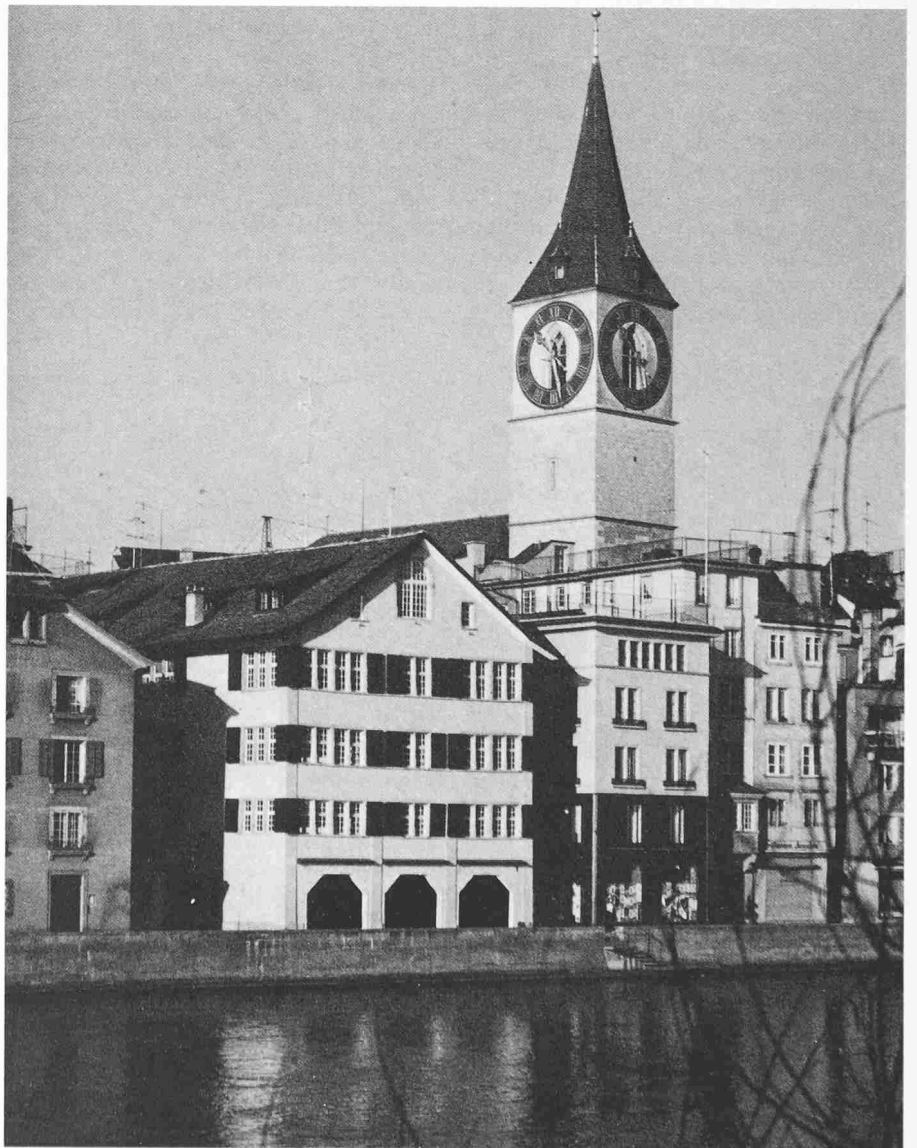
Das «Neuhaus» nach erfolgter Restaurierung
