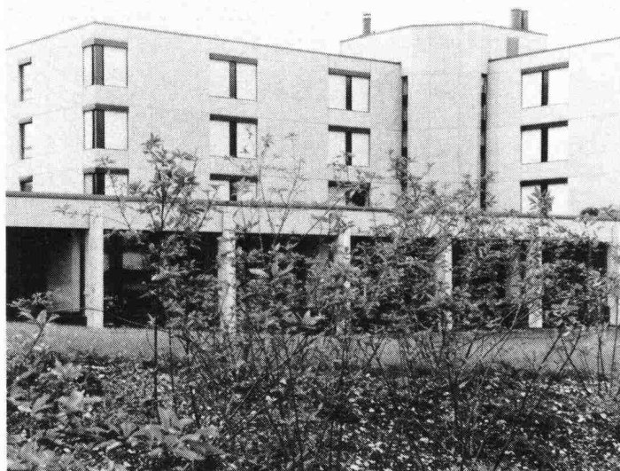
- Ausbildungszentrum Bâloise Münchenstein. Innenisolation.
