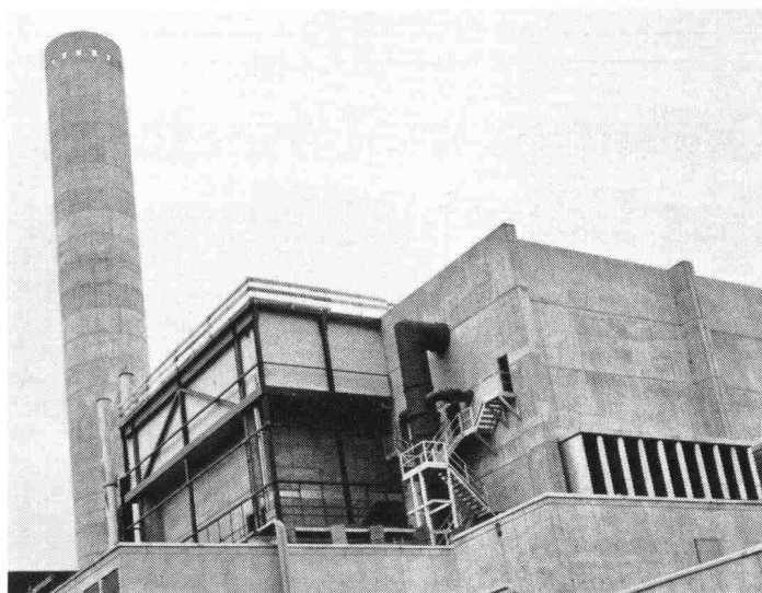
- Kehrlichtverbrennungsanlage Zürich. Wandisolationen.
