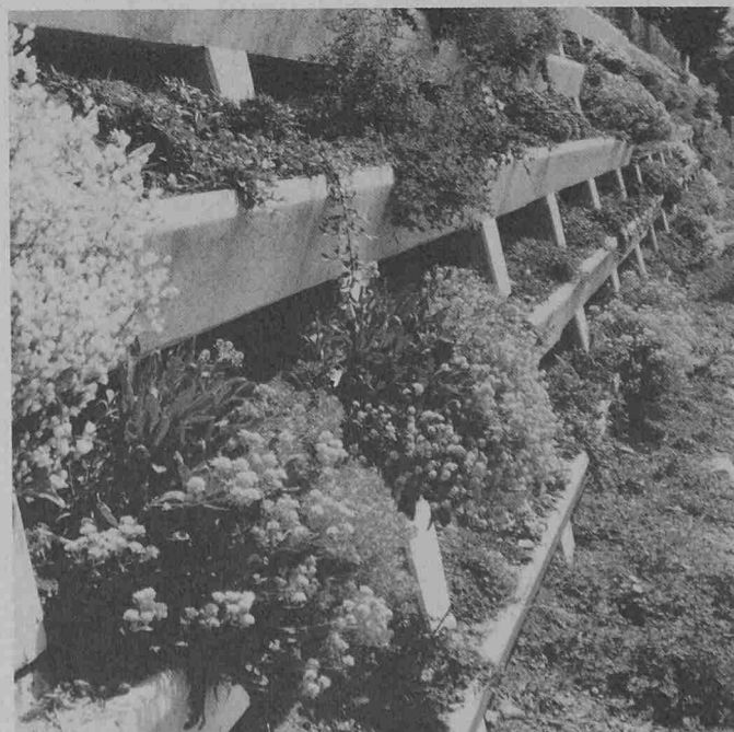
Detail aus einer bepflanzten Stützmauer
