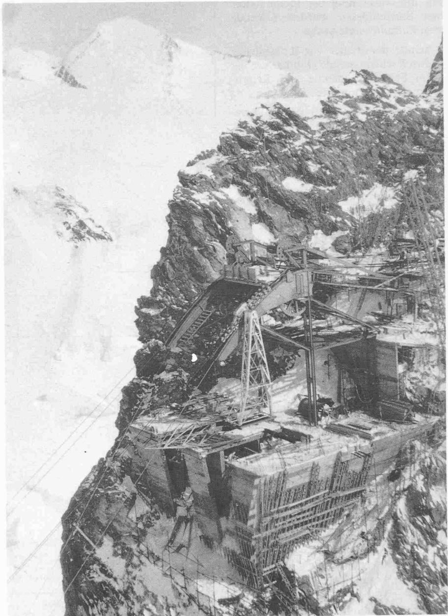
Bild 5. Bergstation im Bauzustand (Foto D.Quinche)
