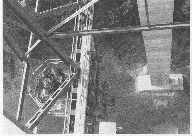
Bild 9. Pfeilerkonsole in Vorfahrt
