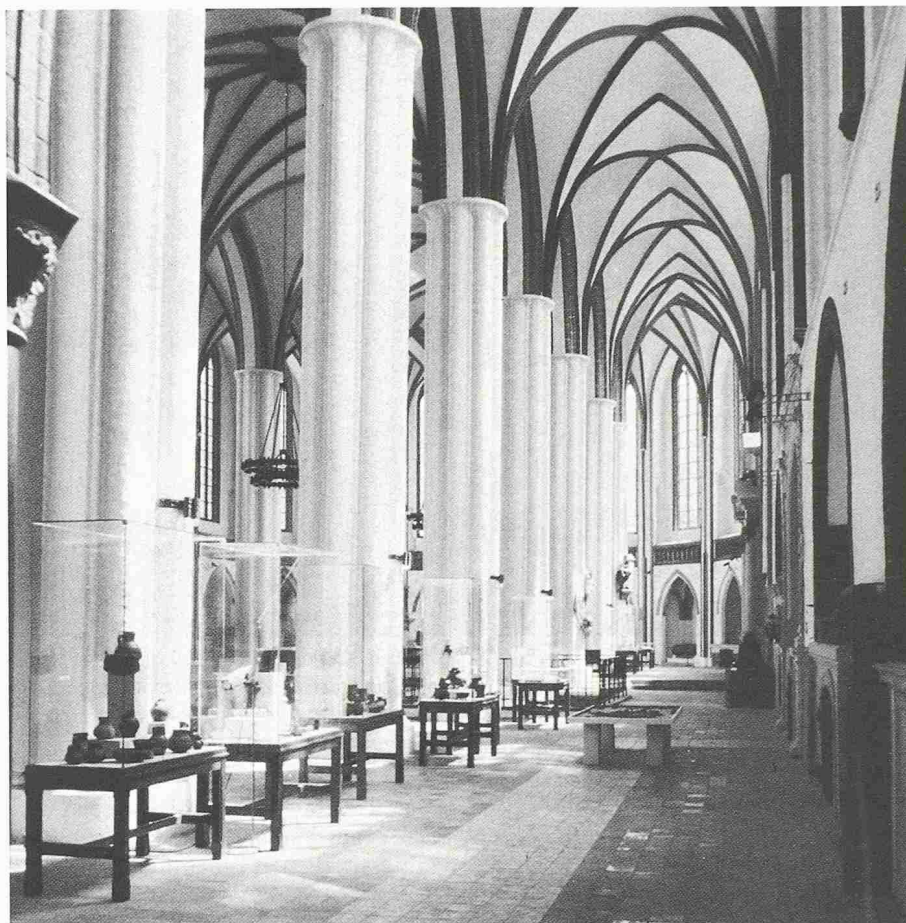
Seitenschiff mit Blick auf den Chor und Kapellenkranz. Im Fussboden ist die romantische Basilika als Vorgängerbau sichtbar gemacht
