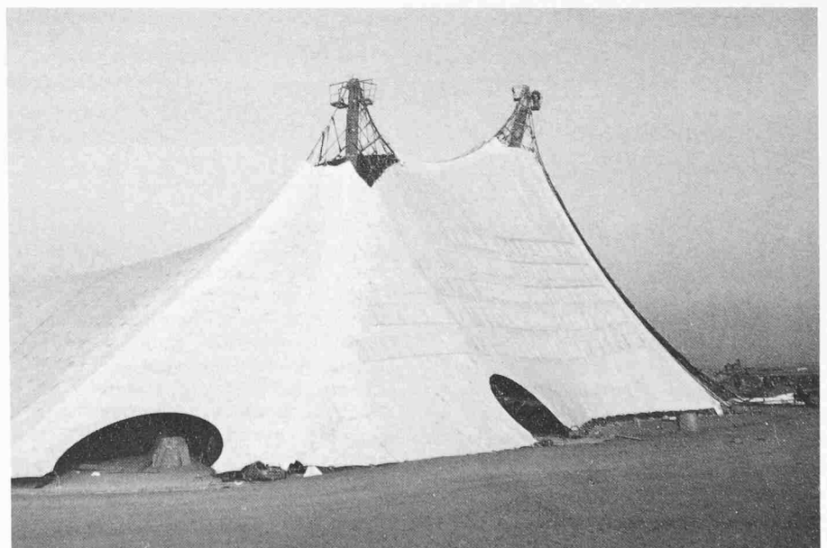
Teilansicht der fertig montierten Aussenmembrane
