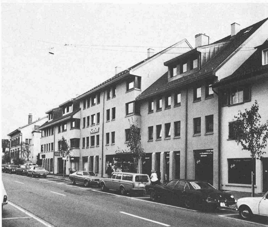
Blick aus der Kasernenstrasse auf die Neubauten aus westlicher Richtung
