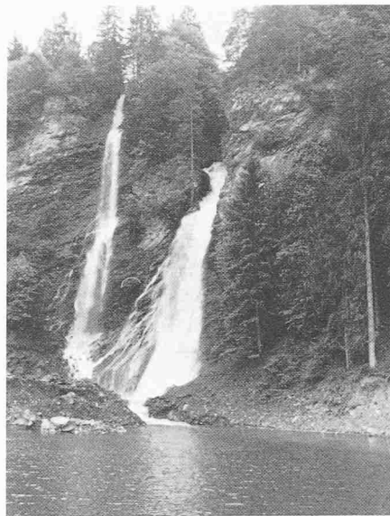
Rechts der Saarfall mit dem neuen grossen Kiesfang, links der Wasserfall der Kleinen Saar während deren Umleitung zufolge des Baues des neuen Ableitungskanals in den Kiesfang des Saarfallles
