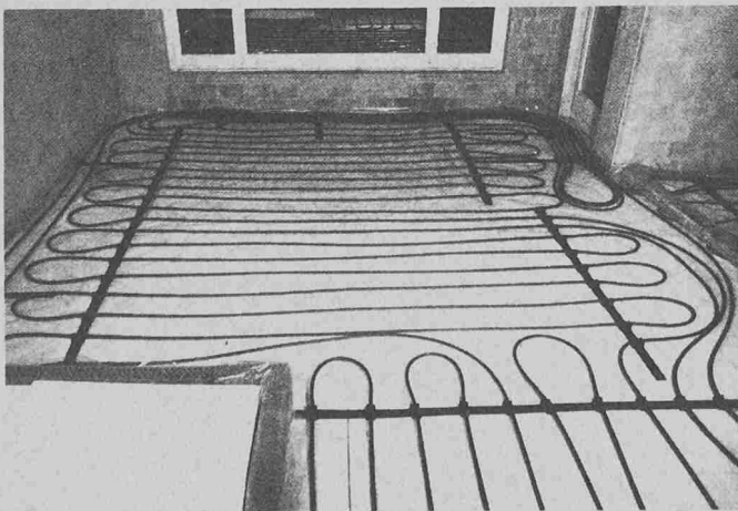
Auf der Wärmeisolation verlegte Unitex-Rohre, unmittelbar vor dem Einbringen des Unterlagsbodens. Beim Fenster sieht man deutlich die zur Kompensation des Kälteabfalles erhöhte Rohr-Konzentration.
