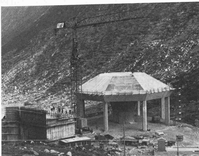
Aussenbauwerk Guspisbach am Gotthardpass mit Zuluftpilz und Betriebsgebäude mit Abluftkamin
