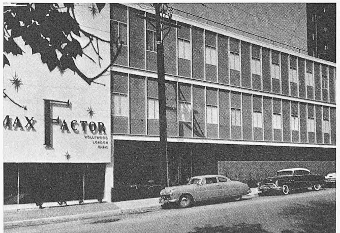
Fig. 9. Immeuble de bureaux Max Factor
