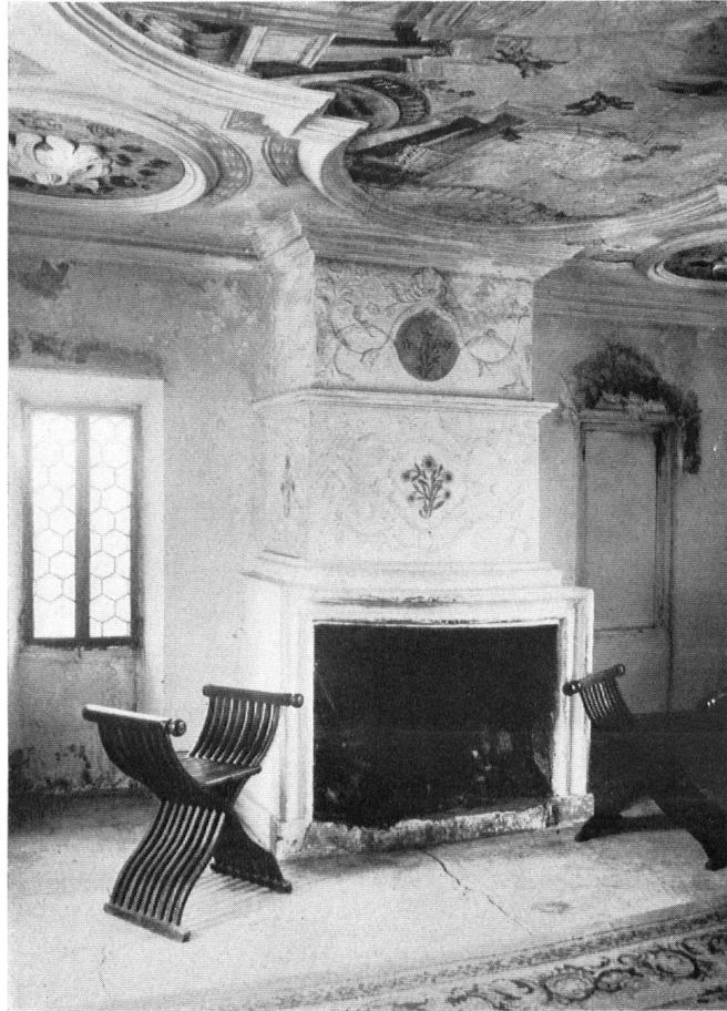
Sommerhaus der Familie Supersaxo (18. Jh.) in Les Mayens de Sion. Die Deckenmalerei und Stukkaturen sind gefährdet. La maison d'été de la famille Supersaxo, aux Mayens de Sion. Les plafonds peints et les stucs du XVIIIe sont en danger. Residenza estiva dei Supersaxo (XVIII secolo) nei Mayens de Sion. I dipinti del soffitto e gli stucchi sono in pericolo.
