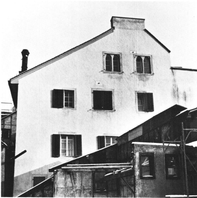
Abb. 20: «Zum Unteren Deutschen Haus» (Römergasse 7): Bisweilen finden sich die gekuppelten Spitzbogenfenster bis ins Giebfeld.
