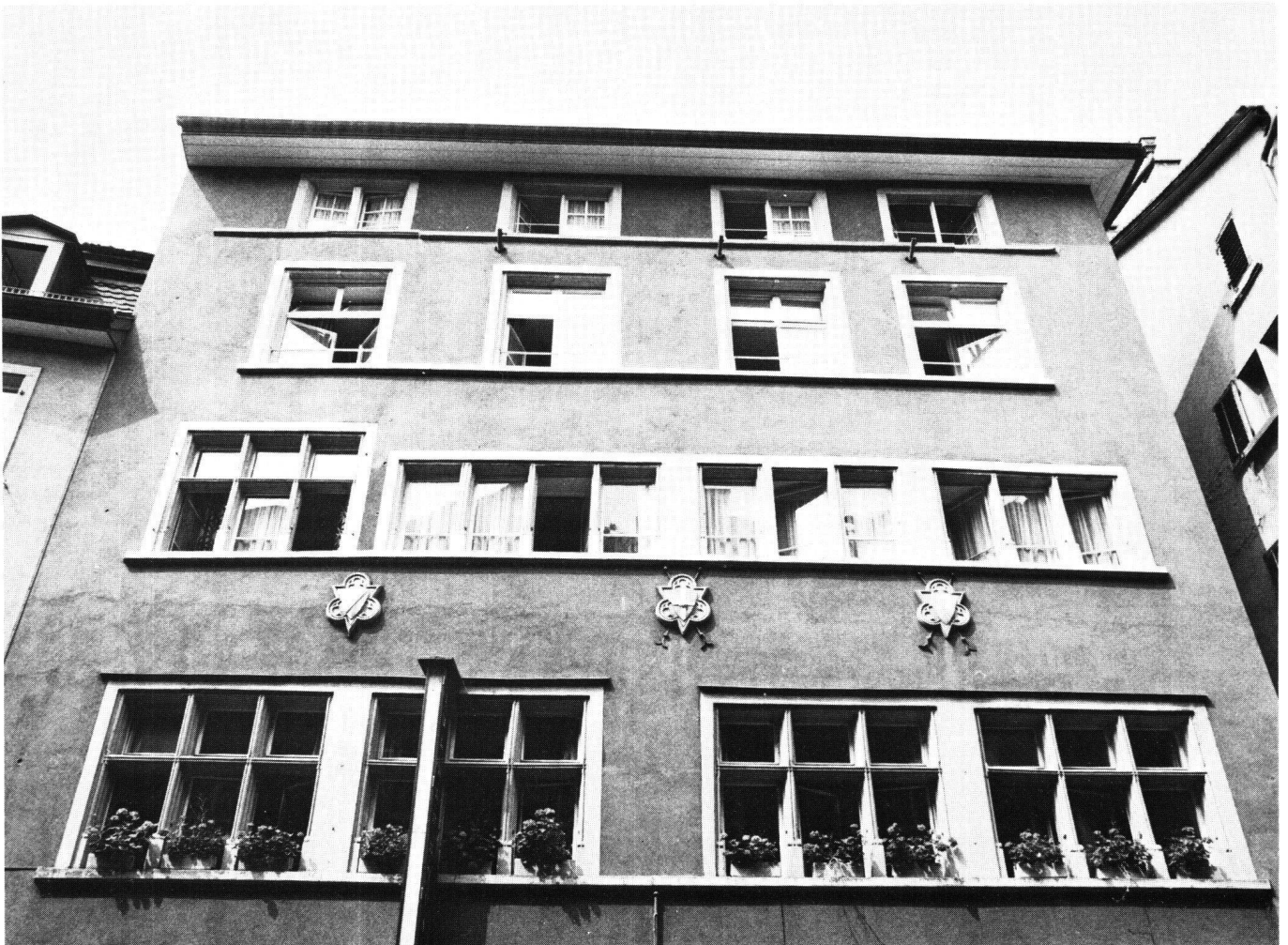
Abb. 26: «Zum Roten Haus» (Marktgasse 17): Die zwei Dreiergruppen von 1576 mit Kreuzstöcken im ersten Obergeschoss sind die am «reichsten» (!) profilierten Fenster des 16. Jahrhunderts in Zürich: Wandung und Pfosten sind doppelt gekehrt und mit Renaissancevoluten versehen.
