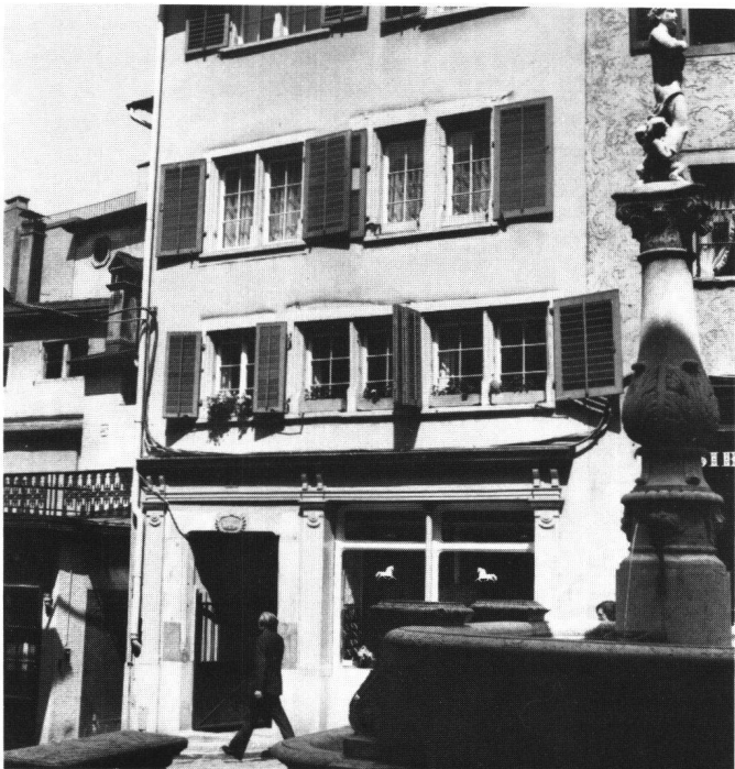
Abb. 28: Das Haus «Zur Rüschi» (Spiegelgasse 7) ist nicht etwa das einzige «wüste» Beispiel, bei welchem gleich sterweise Klapppläden den spätmittelalterlichen Fensterbändern vorgeschnallt wurden...
