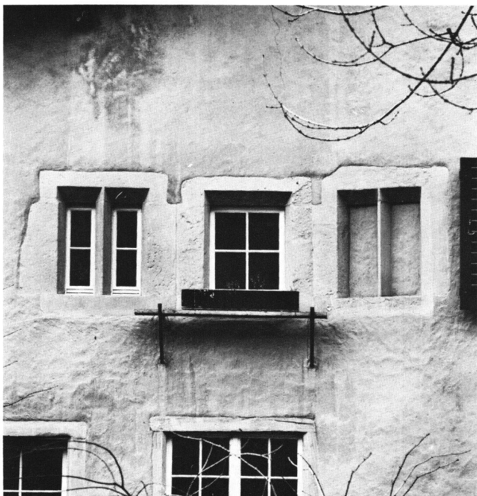
Abb. 24: «Zum Ligöd» (Steinbockgasse 7): Die gedrungenen gotischen Pfostenfenster – beim mittleren fehlt der schlankgeschrägte Pfosten – gehören in das späte 13. Jahrhundert.
