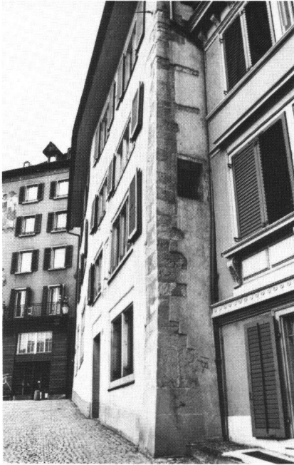
Abb. 4: An der Südostecke des «Lindentores» (Hirschengraben 7) finden sich gleich zwei rechteckige Lochfenster, eines davon ist zugemauert.
