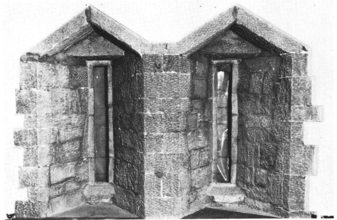
Abb. 10: «Zum Oberen Kürass» (Augustinergasse 21): Gewände, Sturz und Bank sowie die tiefe Nischenleibung sind aus sorgfältig bearbeiteten Sandsteinquadern gefügt.
