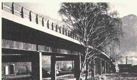
Strassenbrücke über eine in Betrieb stehende Eisenbahnstrecke
