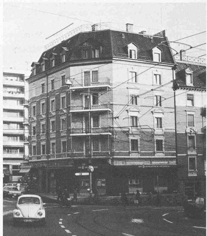
Bild 7. Strassenfassade nach der Aussenrenovation
