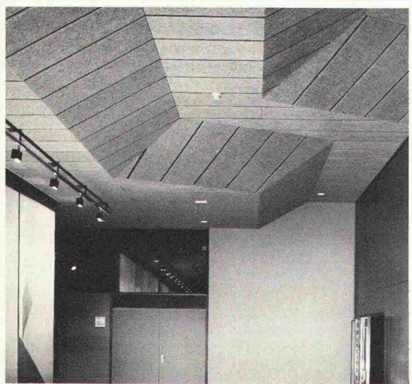
Mensa-Mehrzweckhalle ETH Zürich
