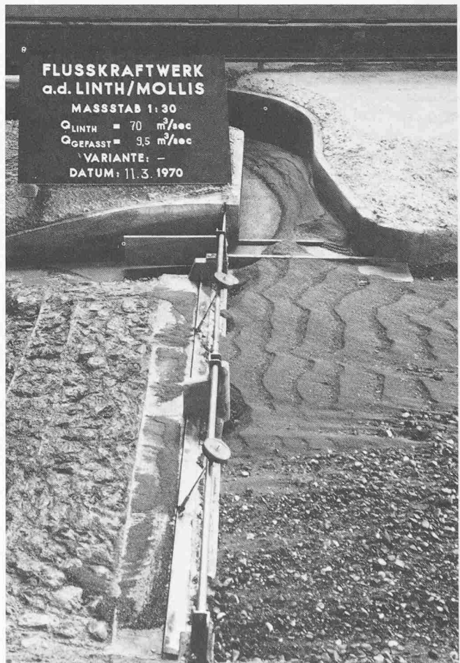
Bild 6. Bei bestehender Fassungsanlage starkes Eindringen von Geschiebe
