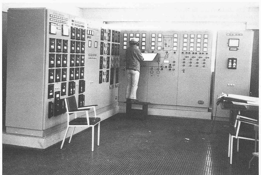
Bild 20. Zu hoch angeordnete Instrumente
