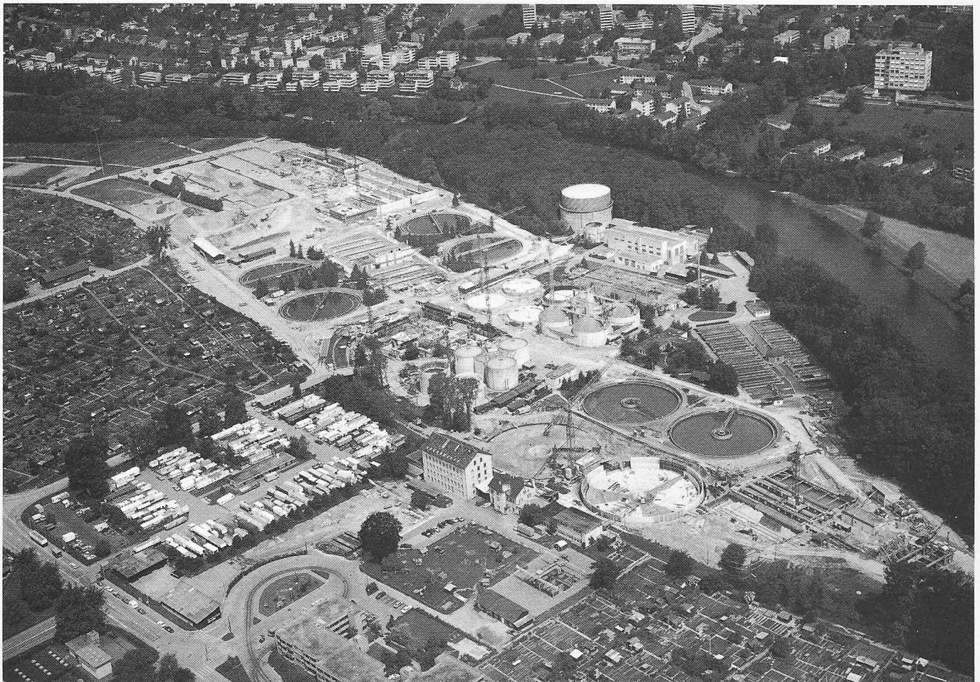
Kläranlage Werdhölzli, Ansicht von Süden. Baustelle im Juli 1981. Rechts die mechanische Reinigungsstufe mit der alten Rechenanlage, den rechteckigen Öl-/Feinsandfängen und die runden Vorklärbecken. Im Zentrum die Schlammbehandlung und die Baugrube des neuen Betriebsgebäudes. Links davon die bestehende, biologische Reinigungsanlage und im Hintergrund die Baustelle des neuen biologischen Anlageteiles
