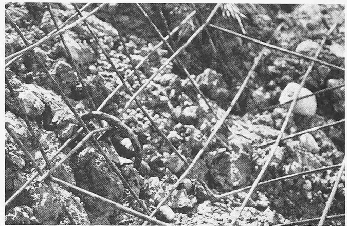
Schiechtelgitter sind dreidimensional verformte Armierungsnetze, die zusätzlich verstrebt worden sind. Sie wurden mit Armierungsseisen auf dem Untergrund fixiert
