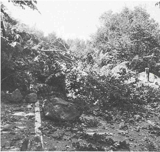
Bild 2. Verschüttete Brünigstrasse von unten gesehen
