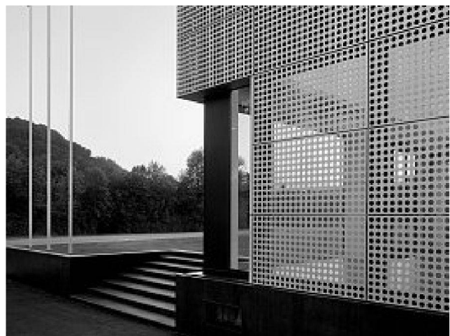
Eloxierte Lochbleche bilden die dünne Fassadenhaut.
