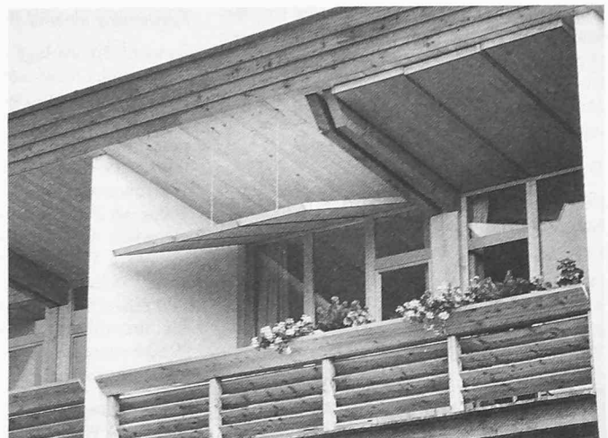
Der hochklappbare Laden bildet einen integrierenden Bestandteil der Solararchitektur
