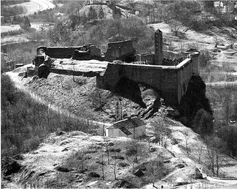
Burg Mesocco. Die Anlage wurde wahrscheinlich erst nach 1251 erweitert und zum Sitz Alberts III. von Sax-Mesocco, wo 1273/74 die Walsen im Rheinwald ihren Vasalleneid ablegten (Foto: Riccardo Fasani, Mesocco).
