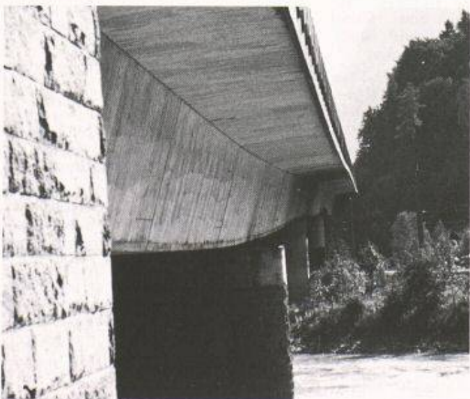
Bilder 1 und 2. Spannbetonüberbauten der Innbrücken in Kufstein über dem um 1,28 m abgesunkenen Flusspfeiler: vor (Bild 1) und nach dem Anheben in die ursprüngliche Lage (Bild 2).
