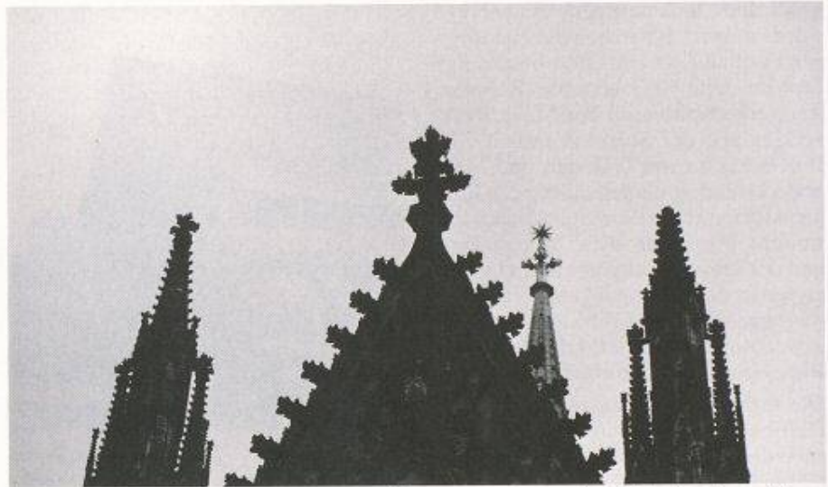
Bild 8. Schaden am Kölner Dom: Auf der Turmspitze rechts fehlt die Kreuzblume
