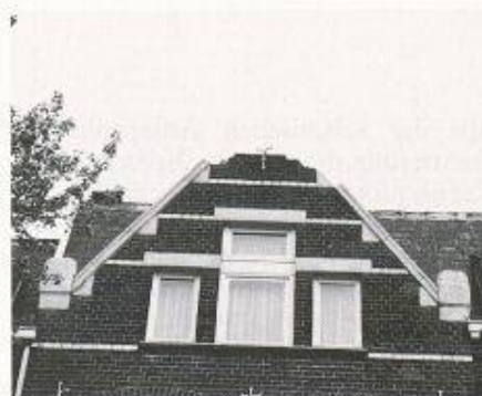
Bild 6. Beispiel für Mauerwerkschäden: Ausbruch an älterem Wohnhaus in Oberbruch/Heinsberg
