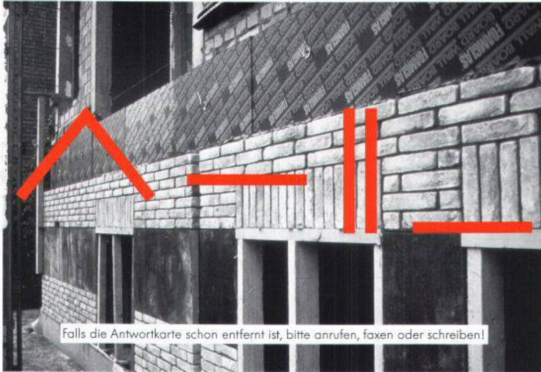
FOAMGLAS®-T5 und FOAMGLAS®-WALL BOARD, eine Weiterentwicklung von Pittsburgh Corning für die Dämmung von Vorhangfassaden und zweischaligen Wänden (im Bild FOAMGLAS®-WALL BOARD mit Backsteinvormauerung am Beispiel eines Verwaltungsgebäudes).
