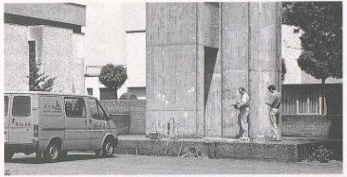
Messung der Eisenüberdeckung im Rahmen der Zustandsanalyse
