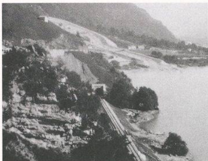
Bild 8. Mit dem Bau zahlreicher Fluss-verbauungen musste die Bahnlinie vor der zerstörerischen Kraft des Wassers geschützt werden. Diese Bauwerke erforderten zum Teil markante Eingriffe in die Landschaft
