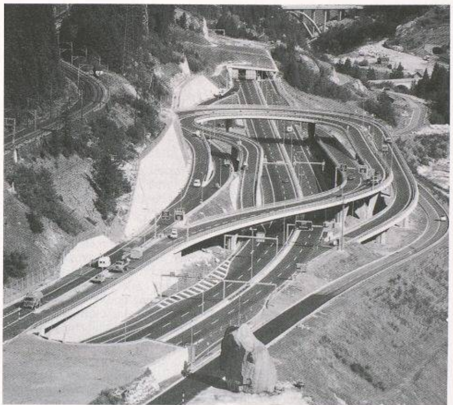
Bild 11. Das Ausbruchmaterial des Gotthardtunnels schafft den notwendigen Platz für den Verkehrsknoten vor Göschenen, welcher den Anschluss an die alten Passübergänge Oberalp und Furka gewährleistet
