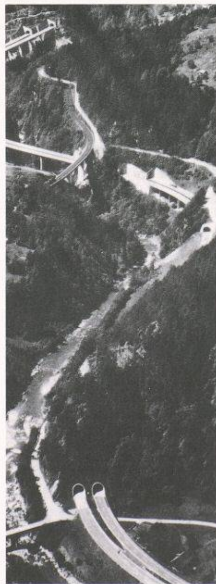
Bild 10. Zahlreiche Viadukte und Tunnels ermöglichten auch im engen Talabschnitt oberhalb von Amsteg eine grosszügige Linienführung
