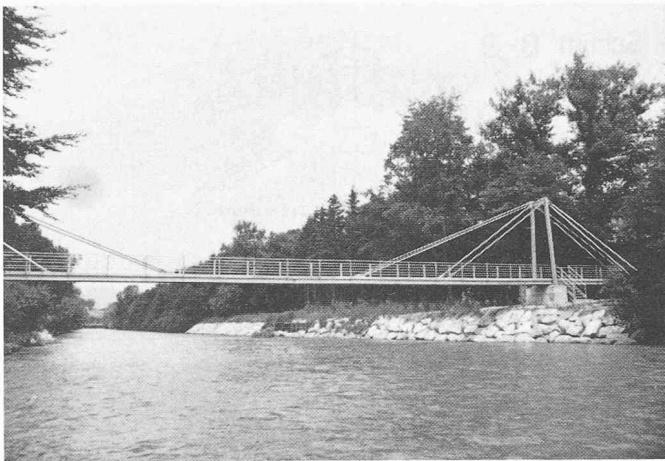
Bild 2. Ansicht des Steges von Oberwasserseite
