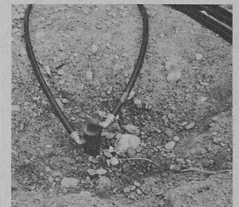
Angeschlossene Erdsonde
