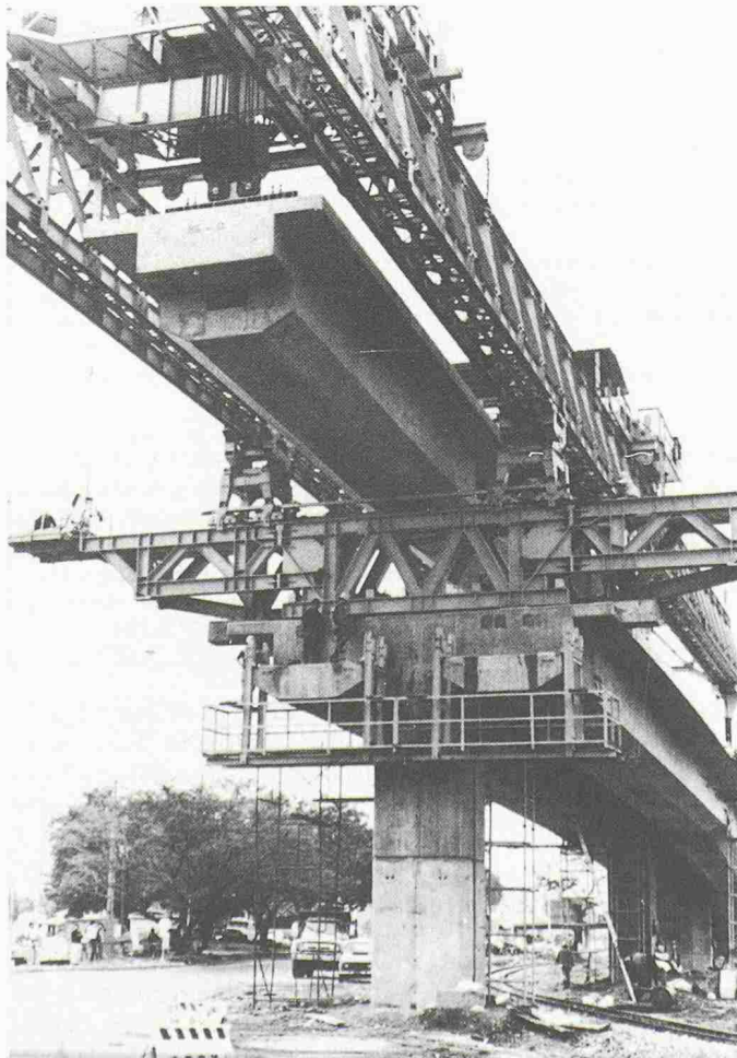
Bild 5. Metro Medellin in Kolumbien: Einbau eines 30 m langen und 230 t schweren Spannbeton-Fahrbahnträgers mit Verlegegerät (Schambeck)
