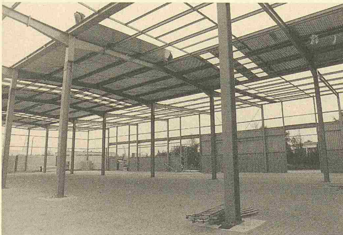
Fabrikhalle in Bremen: vollständig demontabel und wiederverwertbar
