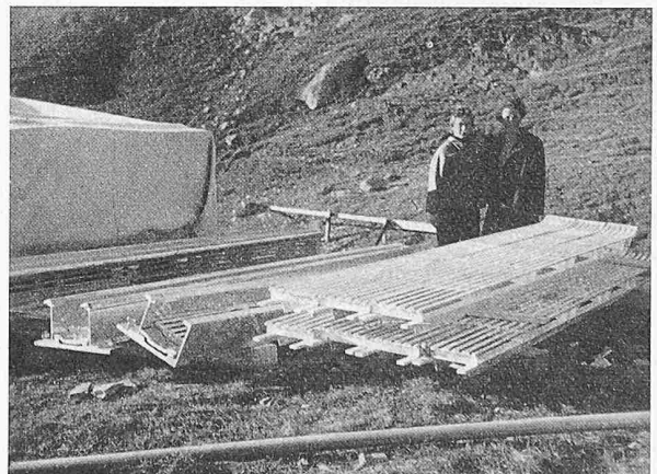
Bild 4. Werk Lucendro, Wasserfassung Fortunei. Verzinkte Zwillingsträger und Feinrechentafeln vor der Montage
