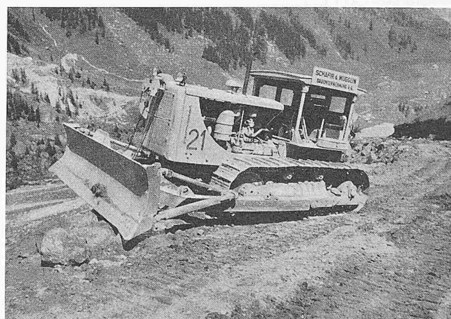
Bild 2. Bulldozer Caterpillar D 8, Gewicht 22 t, Motorenleistung 190 PS
