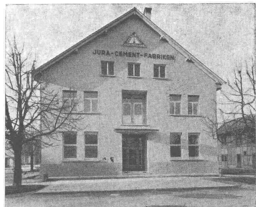
Jura-Portland-Cementfabrik, Wildegg, Verwaltungsgebäude Malermeister: A. Cavinato, Holderbank
