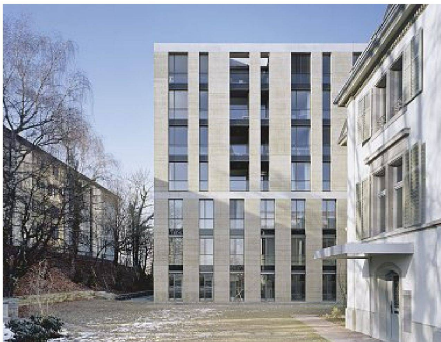
Wohngebäude Malzturm, rechts das Braumeisterhaus
