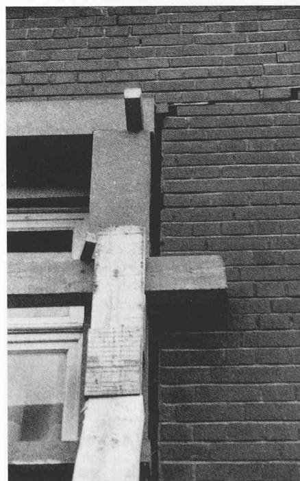
Bild 8. Die massive, seitliche Fenstereinfassung ist um mehrere cm verschoben. Dies deutet auf eine kurzzeitige Entlastung in vertikaler Richtung hin
